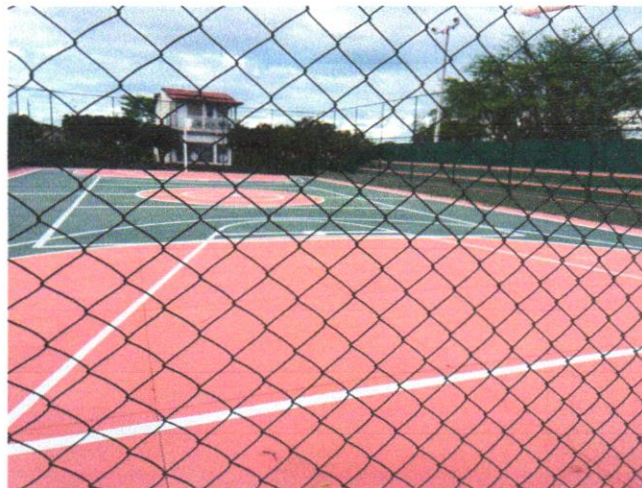
FOTO 01 - ALAMBRADO PARA QUADRA POLIESPORTIVA, ESTRUTURADO POR TUBOS DE AÇO GALVANIZADO, (MONTANTES COM DIÂMETRO 2", TRAVESSAS E ESCORAS COM DIÂMETRO 1 1/4"), COM TELA DE ARAME GALVANIZADO, FIO 10 BWG E MALHA
